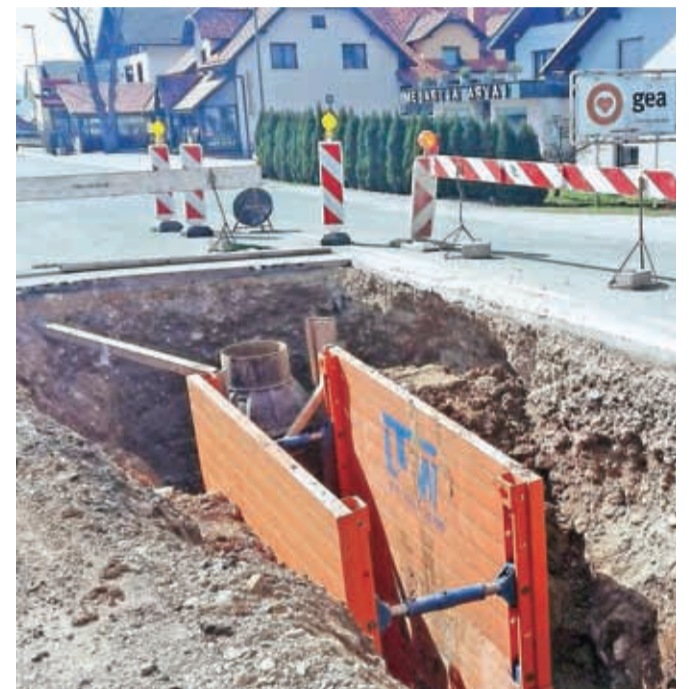
V Britofu se je gradnja komunalnih vodov že začela.
